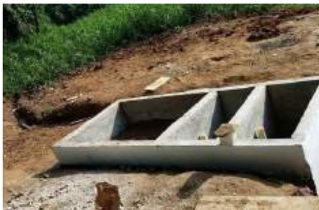
**Figura 7.** Construcción del Biofiltro. Fotografía tomada por el equipo de investigación cuando el Biofiltro estaba en proceso.
