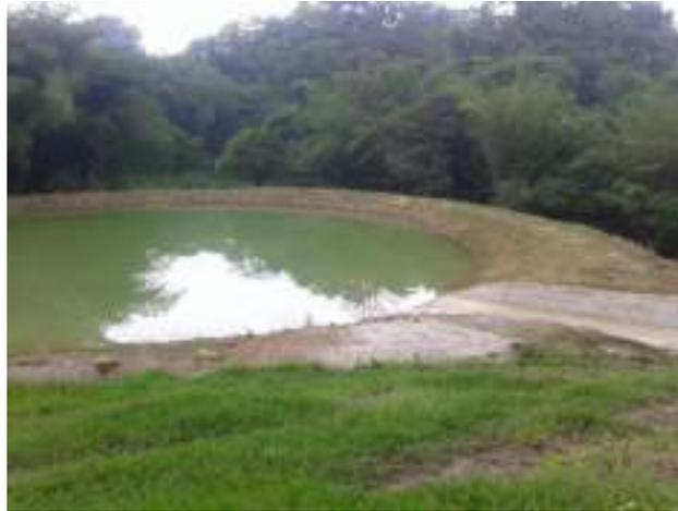
**Figura 7.** Supervisión de obra en Tandezumadz, Huehuetlán, S.L.P. Bordo de tierra compactada
