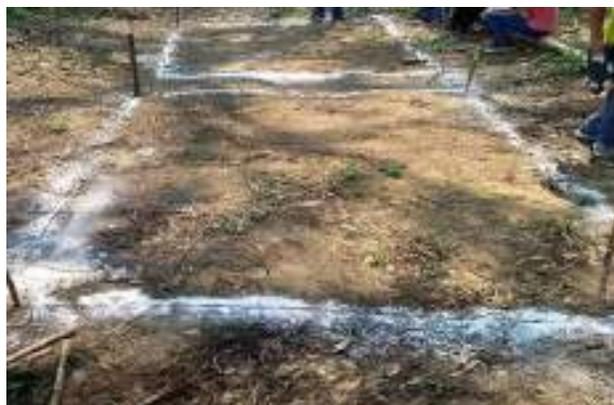
**Figura 6.** Trazo del Biofiltro. Fotografía tomada por el equipo de investigación cuando se inició con los trazos para construir el Biofiltro.
